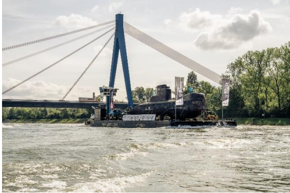
Am Freitagmorgen, den 5. Juli, legt der flussfähige Ponton der Firma Van der Wees nach Mannheim/Rheinau ab. Quelle TMSNHSP
